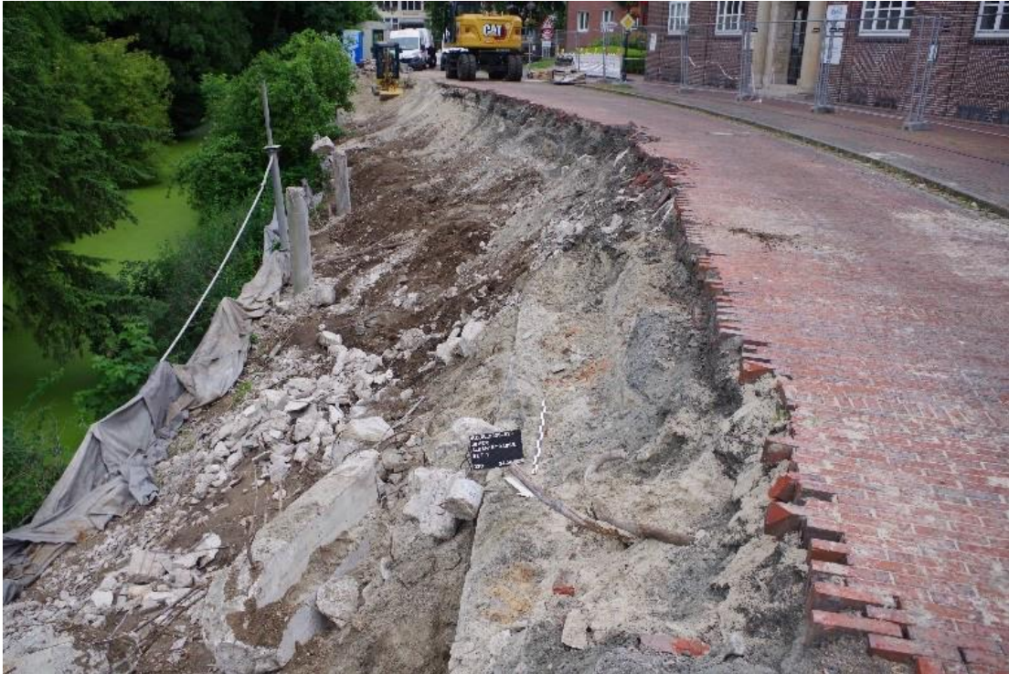
Stand der Freilegungsarbeiten am 24.6.2025 mit beengter Situation zum Schloßgraben, Blickrichtung Südwesten.
