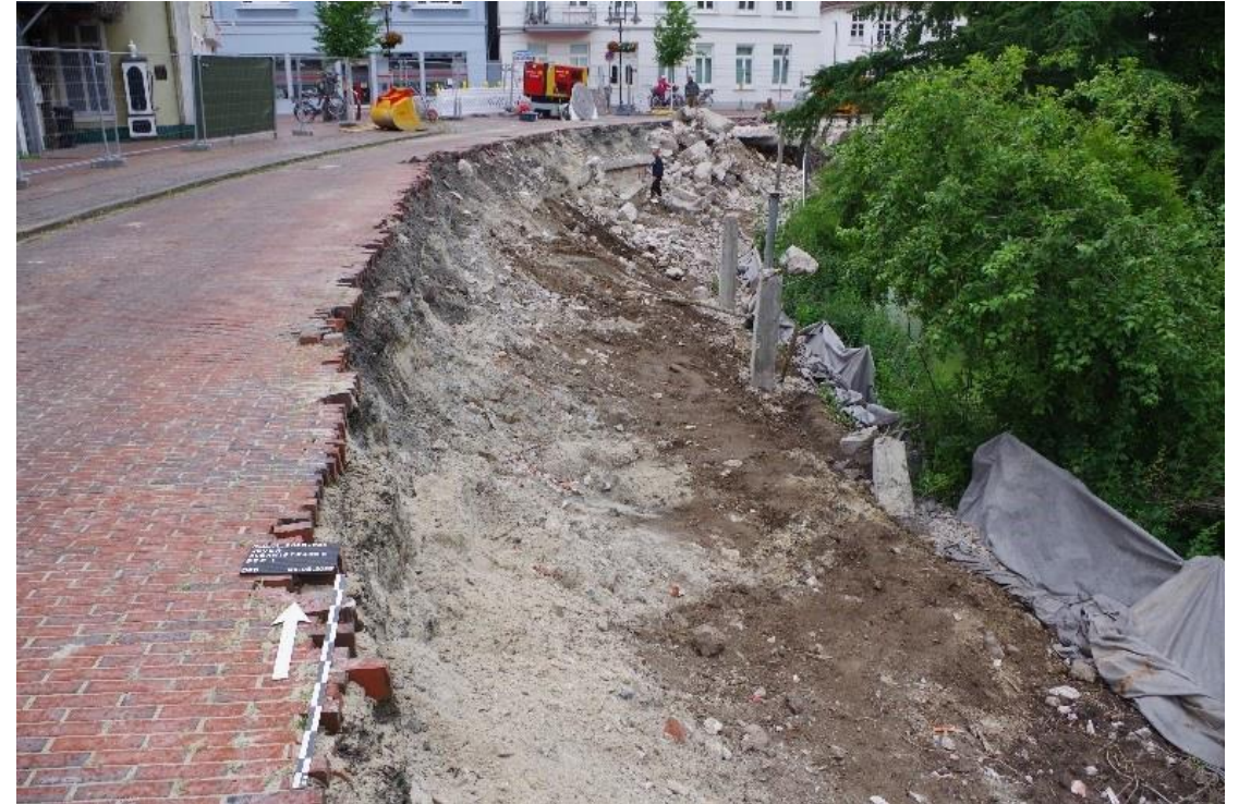
Stand der Freilegungsarbeiten am 24.6.2025 nach Entfernen der Betondecke, Blickrichtung Norden
