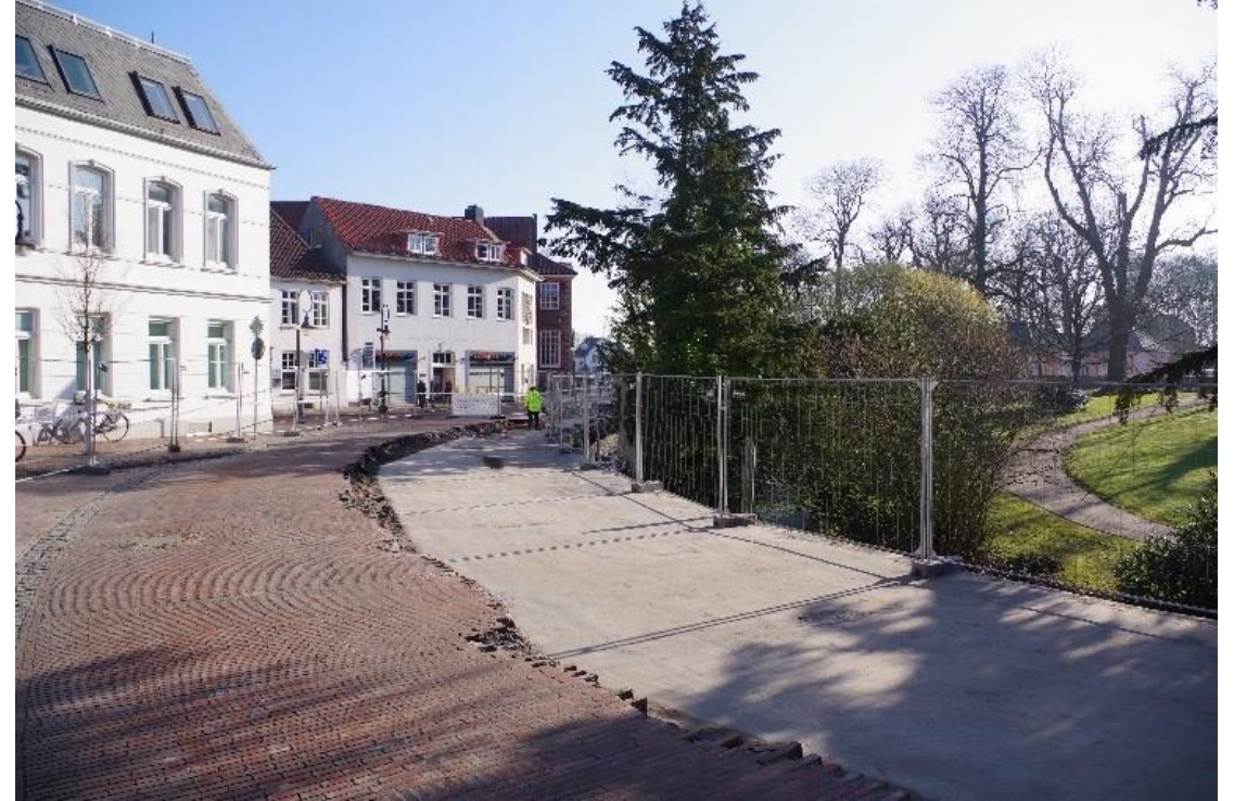
Jever, Albanstraße: Blick Richtung Osten auf die Ausgangslage mit freigelgter Betondecke über dem Mauerverlauf.
