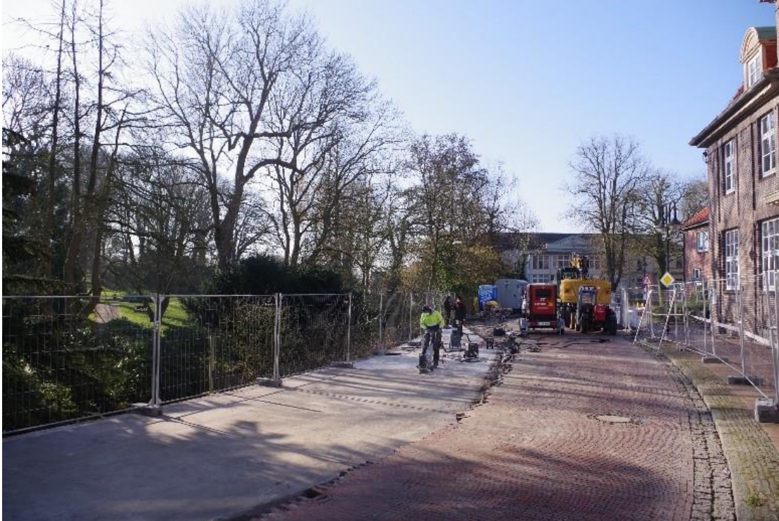
Jever, Albanstraße: Blick Richtung Süden auf die Ausgangslage mit freigelgter Betondecke über dem Mauerverlauf.
