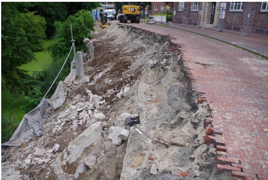
Stand der Freileigungsarbeiten am 24.6.2025 mit beengter Situation zum Schloßgraben, Blickrichtung Südwesten.
