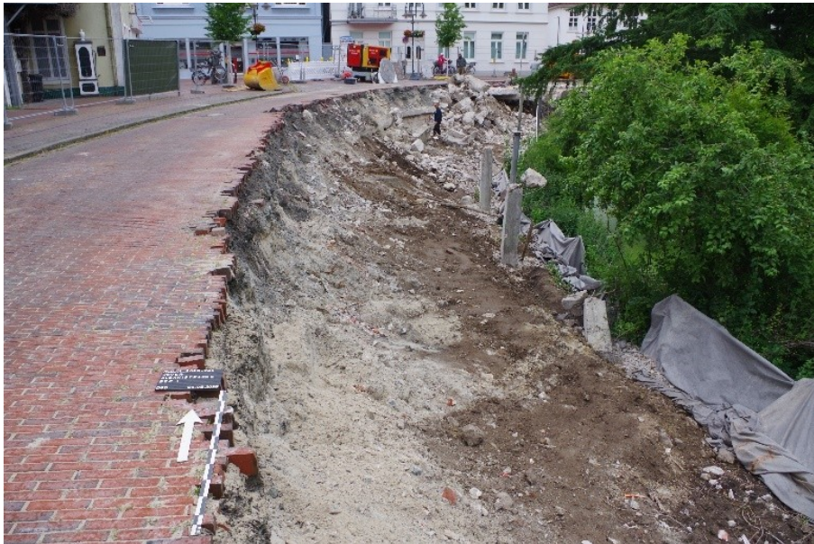
Stand der Freileigungsarbeiten am 24.6.2025 nach Entfernen der Betondecke, Blickrichtung Norden.
