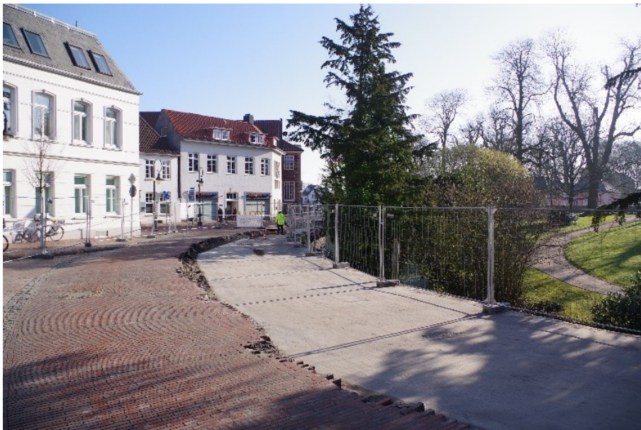
Jever, Albanistraße: Blick Richtung Süden auf die Ausgangslage mit freigelgter Betondecke über dem Mauerverlauf.
