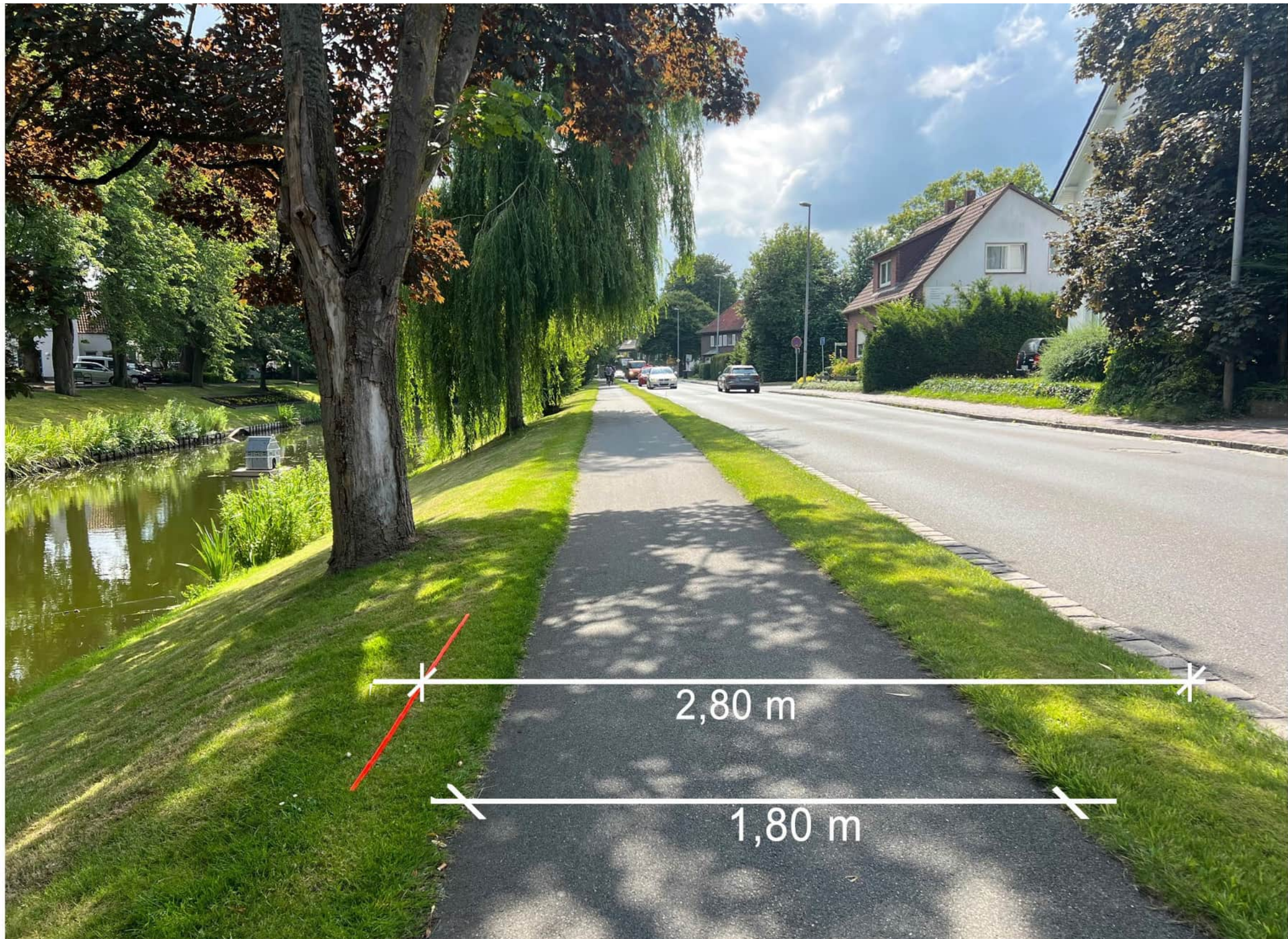
Ausbau Radweg in 2,80 m Breite an der L812; Abbruch Asphalt, Ergänzung Tragschicht im Rasenstreifen.
