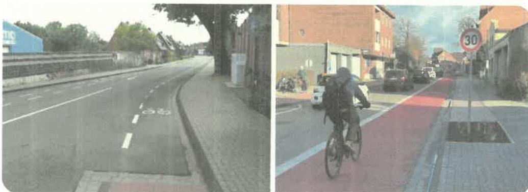
Abbildung 6: Radschutzstreife (links) und Radfahrstreifen (rechts)
